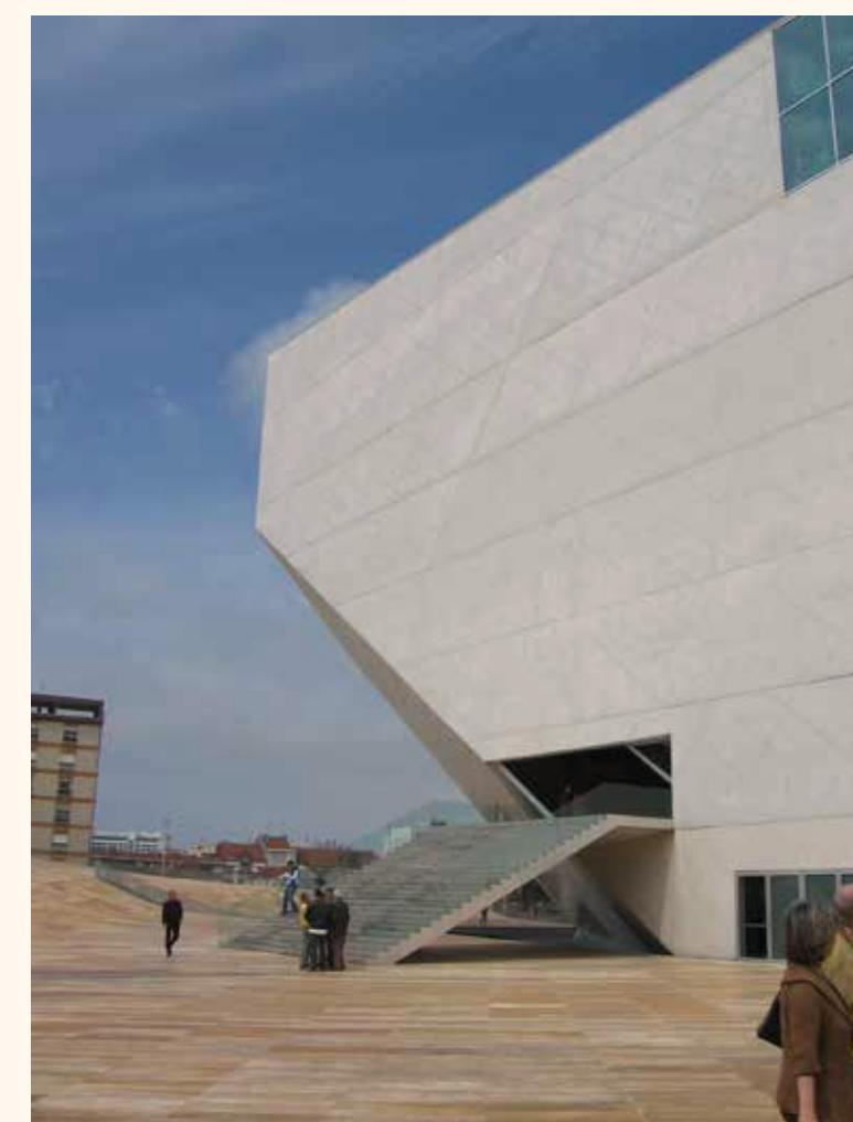
Public square and entrance, Casa da Música, Porto. OMA, 2005.
